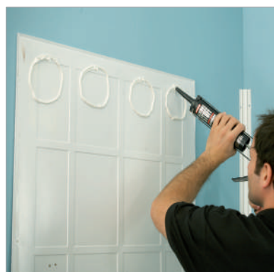
4. Encollage des panneaux au mastic-colle
